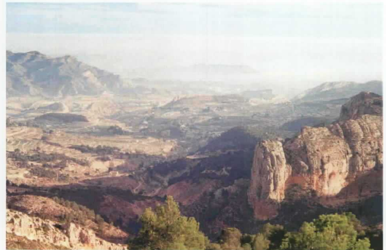
Cerrada de Cabezo de Masset, donde se sitúa el dique de infiltración
