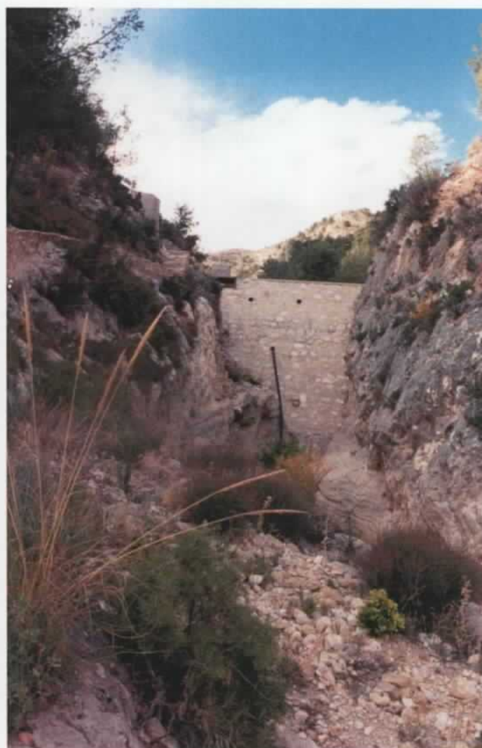
Dique de recarga en la cerrada en el río Coscó
