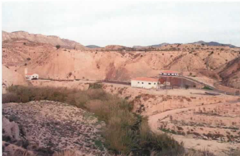
Las aguas residuales depuradas provenientes del núcleo urbano son vertidas al río Torremanzanas
