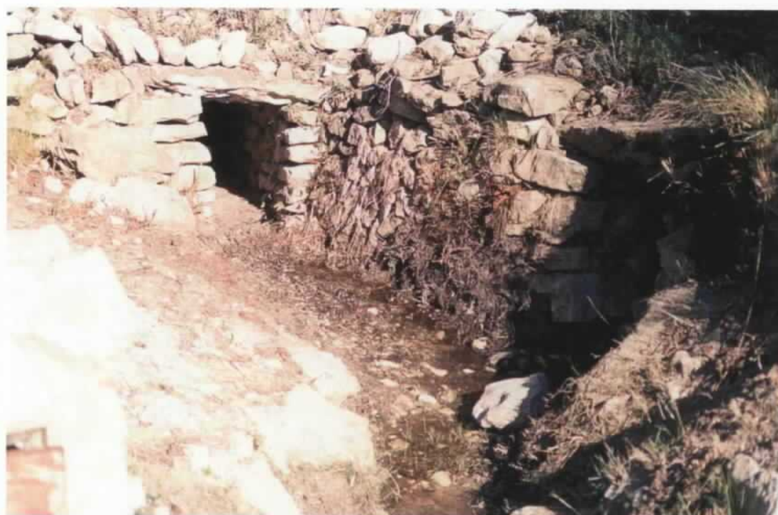
En régimen natural el acuífero de Jijona se drenaba a través del manantial de Rosset, que era el más importante del municipio. Sin embargo, las explotaciones realizadas en los sondeos de abastecimiento han provocado su desaparición.
