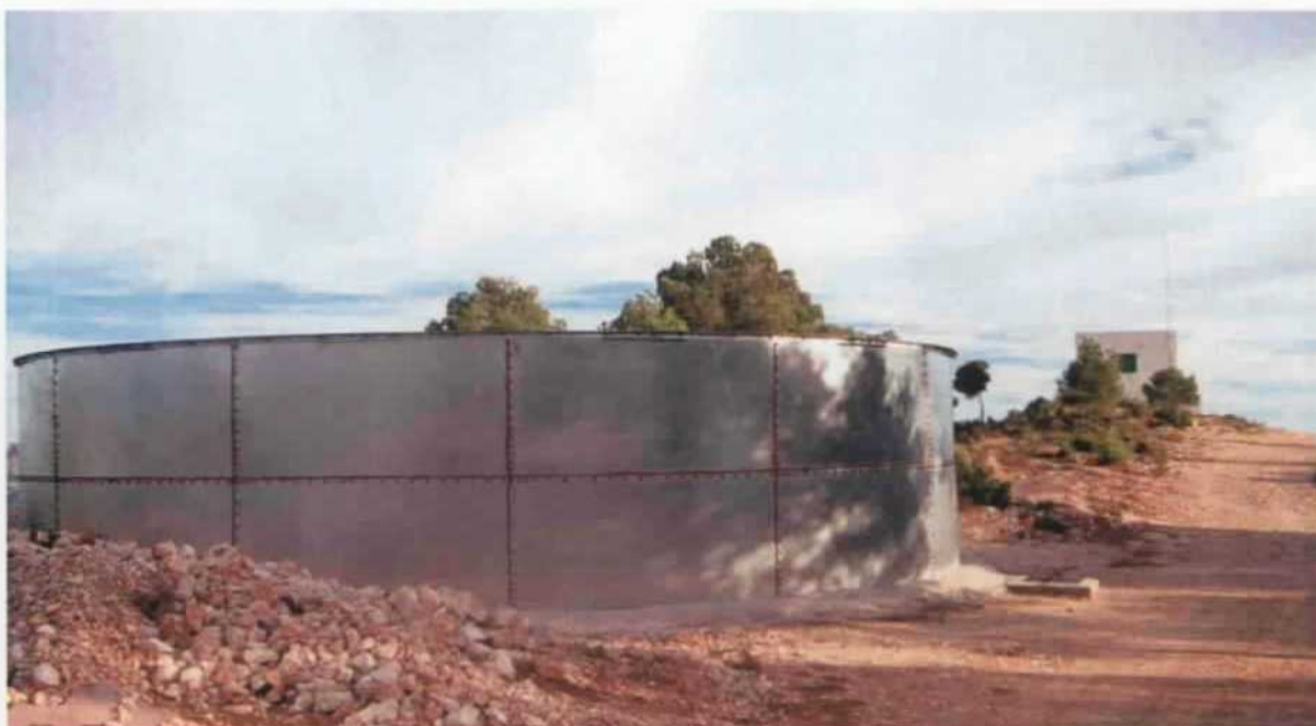
Depósito para la extinción de incendios. Sierra del Madroñal
