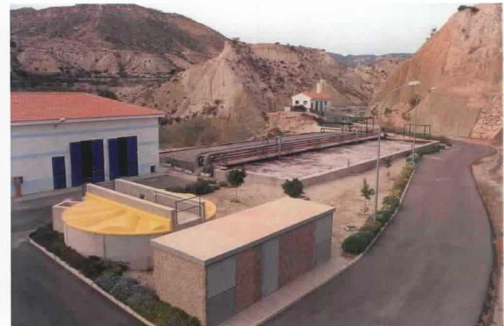
Vista de la estación depuradora de aguas residuales de Jijona
